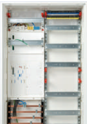
Zählerschrank Armoire de comptage électrique
