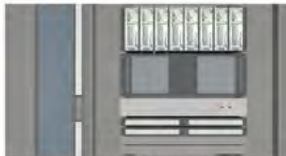
Die zentrale Rufanlagen-Installation im 19"-Verteilerschrank besteht aus Bedienrechner, System-Switch, USV und Stations-Management-Controller
