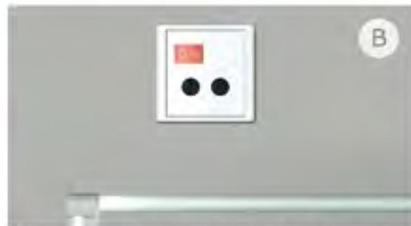
Rufeinheit mit Nebensteckkontakten für sowohl für den Anschluss von mobilen Rufeinheiten, Birtastern u.ä sowie Buchse zum Anschluss und dedizierter Rufauflösung von medizinischen Geräten (Perfusor, Monitor u.a).
