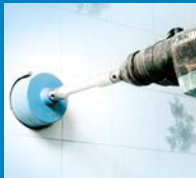
Kernbohrung in der Wand
