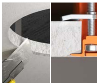
Anfasen der Einbauöffnung für die decken- bzw. wandbündige Montage mittels Cuttermesser.
