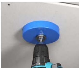
Einbauöffnung \varnothing 120mm mit KAISER Bi-Metall-Fräser erstellen.
