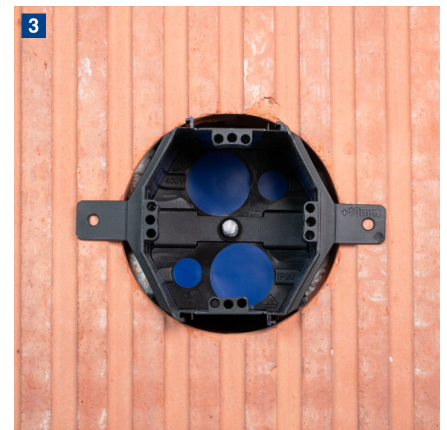
3 Die UI Schaumdose ist nun fertig installiert.
