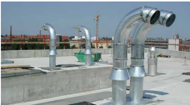
Montierte SHD200 vor Verlegung der Dachabdichtung
