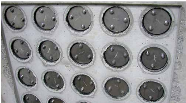
FZR100 / 240 Abdichtung Rohrtrasse
