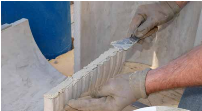
FZRG350/300 mit Spachtelmasse aus Montageset MSET FZRG
