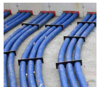
KES MA150 D und Spiralschlauch Hateflex14150
