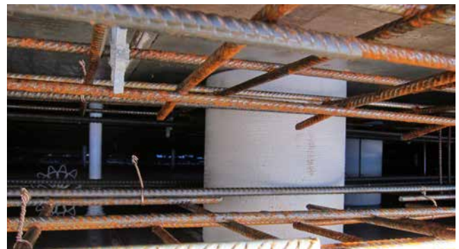
ZVR200/300 in der Schalung fixiert
