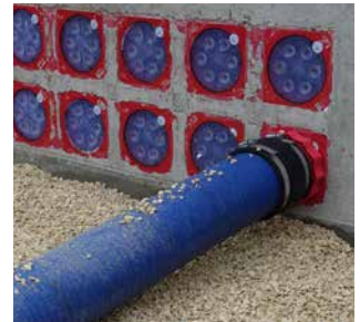
Druckdichter Anschluss an die HSI150-Dichtpackungen
