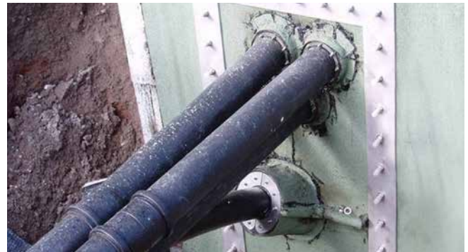
Geteilter Fest-/Losflansch in Anlehnung an DIN 18533
