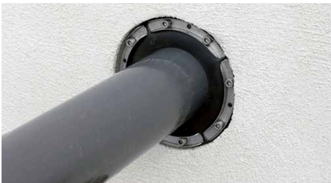
HSD200 1x159 b20 A2/EPDM55 „Schachtabdichtung“
