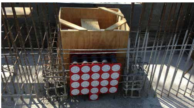
Einbau von Doppeldichtpackung HSI90 vor dem Betonieren
