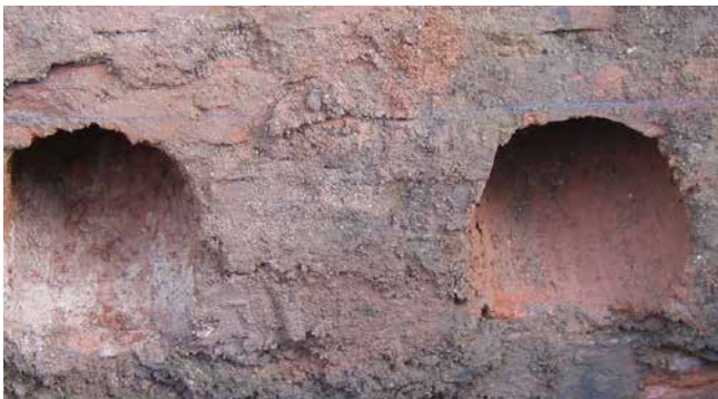
Schräge Kernbohrung in porösem Mauerwerk
