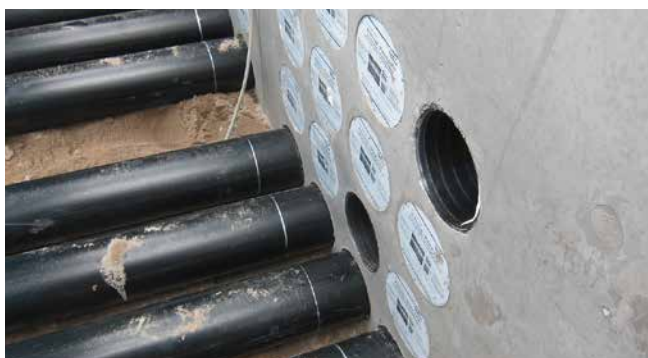
HSI150 GSM eingebaut
