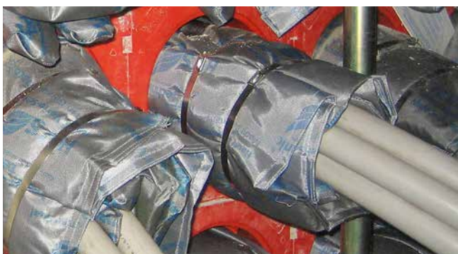
HSS – Einbau der Brandschutzkissen in Dichtpackung HSI150 K2, Abdichtung mit Systemdeckel oder SEGMENTO
