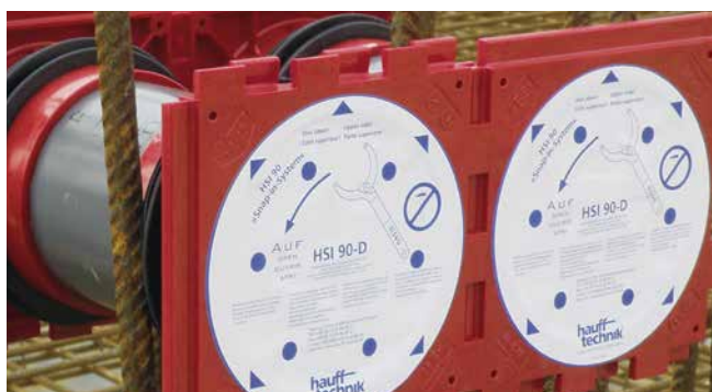
Doppeldichtpackung HSI90 als Paket in Schalung eingesetzt
