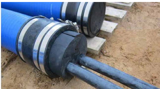
Druckdichter Anschluss des Spiralschlauches Hateflex14150 an die Dichtpackung HSI150 sowie Endabschluss für das Kabelschutzrohr
