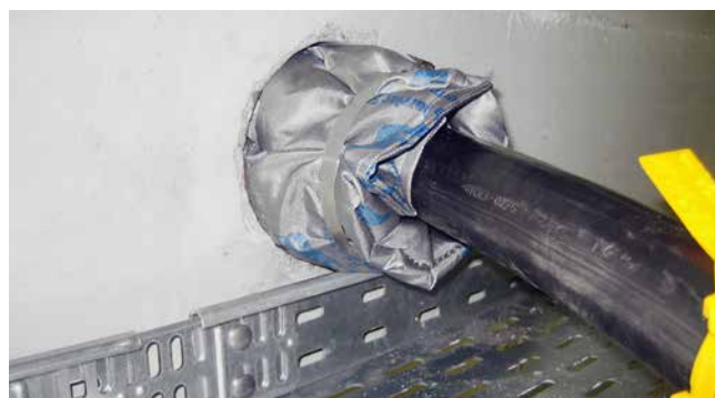
HSS – Einbau in Kernbohrung mit HRD Ringraumdichtungen
