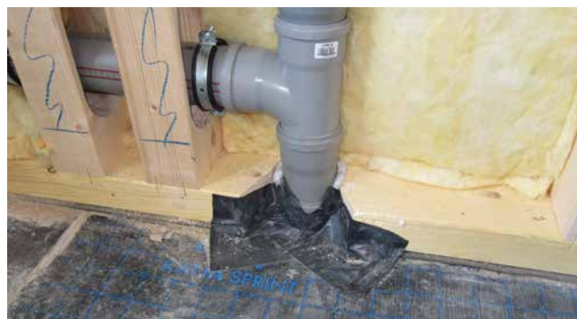
Schwierigkeit: Einbindung der Dampfsperre
