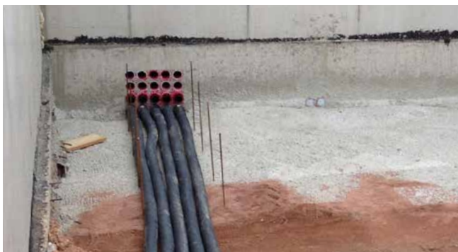
Wellrohranschluss HSI90 D1x75 KS WR
