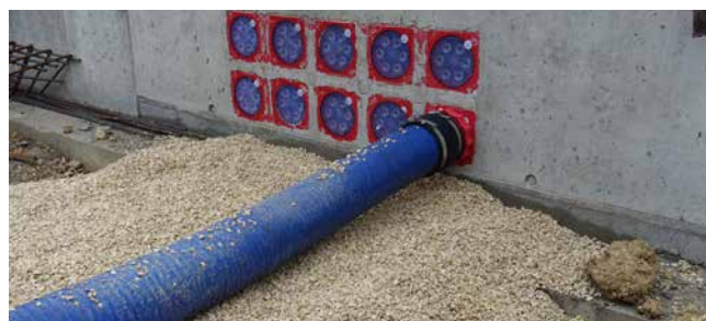
Anschluss des Kabeleinführungssystems KES MA150 D
