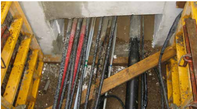
Bauseitig vorhandene rechteckige Aussparung – muss nachträglich abgedichtet werden
