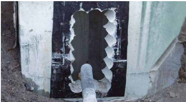
Hochspannungskabel und Schutzrohre müssen nachträglich in Schachtwand abgedichtet werden
