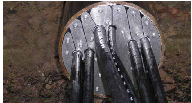
HRD200 G b30 in einem Stahlrohr
