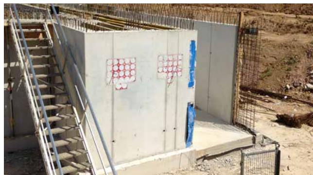
Paket HSI90 Doppel-Dichtpackung nach dem Betonieren: Hier folgt der Leerrohranschluss
